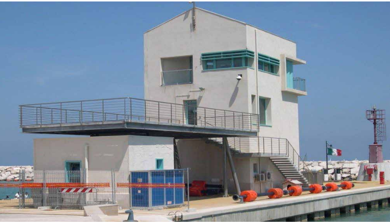
Torre di controllo
