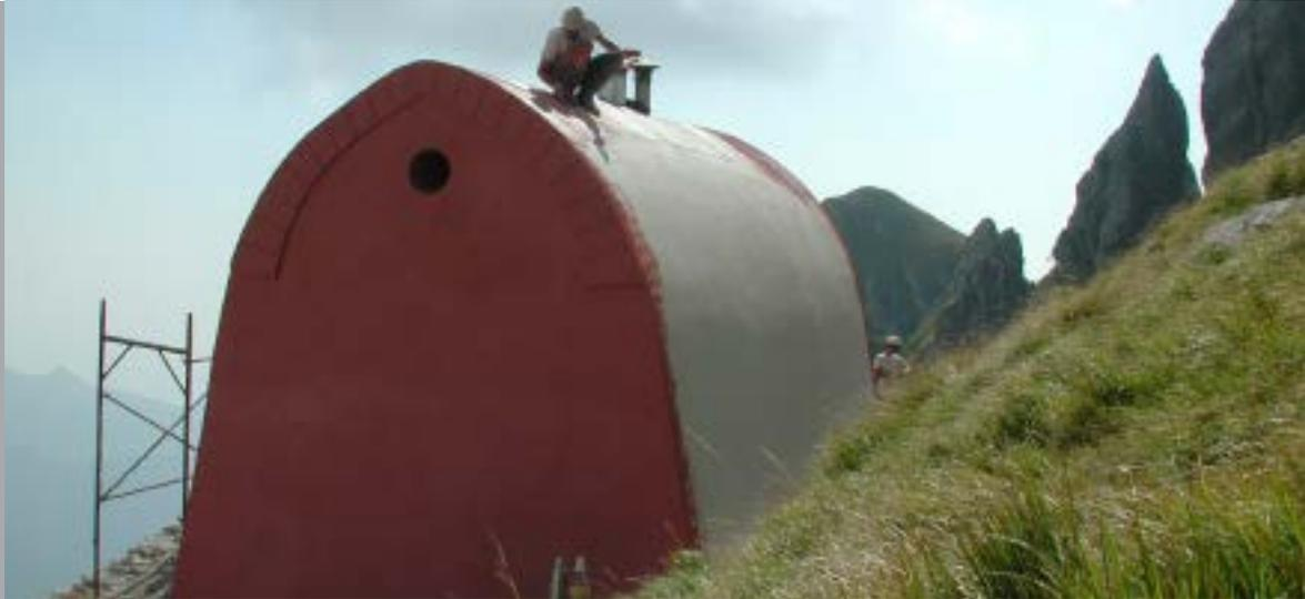
Le opere realizzate hanno consentito di ripristinare la funzionalità e la qualità dell'intero edificio, previo totale risanamento dell'intonaco esterno ed interno e degli infissi. Il primo intervento che si è reso necessario è stato quello di demolire l'intonaco esterno ed interno, ripulendo da parti umide e ammalorate tutta la struttura portante costituita da muratura in pietra e malta non sempre ben compattata e coesa.
