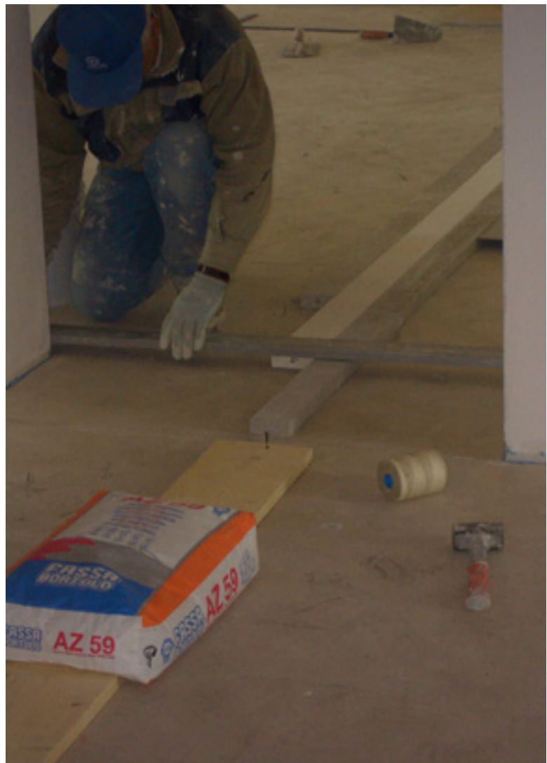
Tutte le foto sottostanti documentano la posa dei rivestimenti marmorei con il superadesivo AZ 59 FLEX
