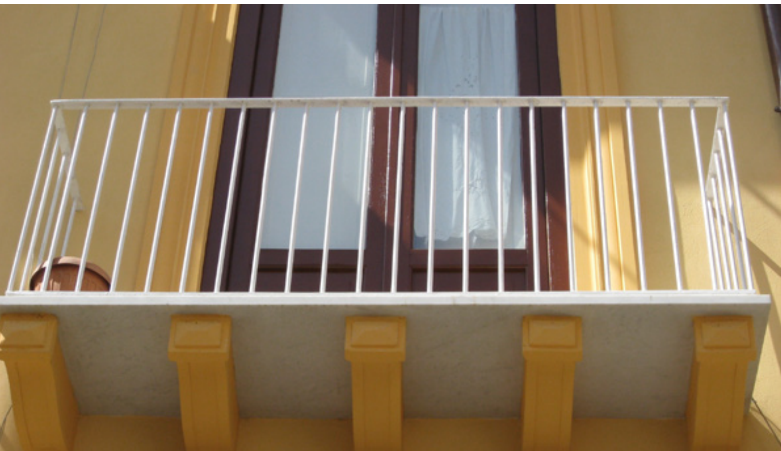
Balcone dopo l'intervento
