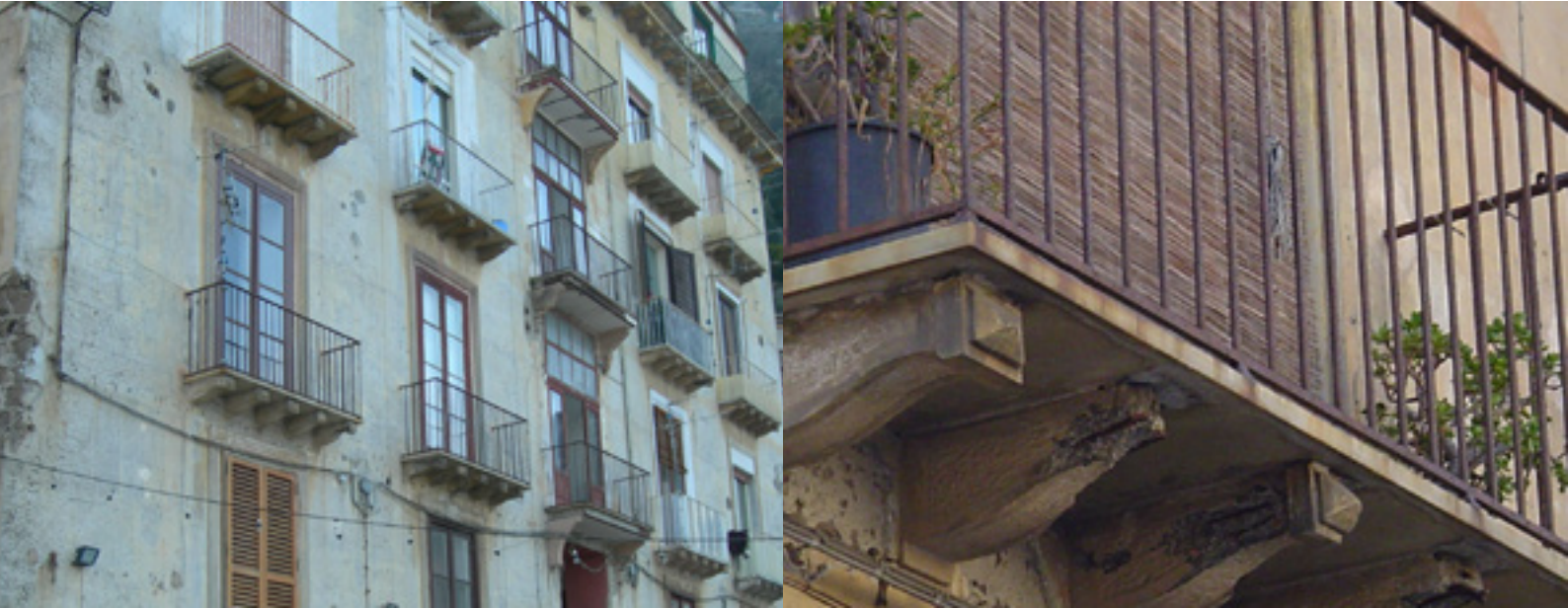
Immagini dello stato dell'immobile prima dell'intervento
