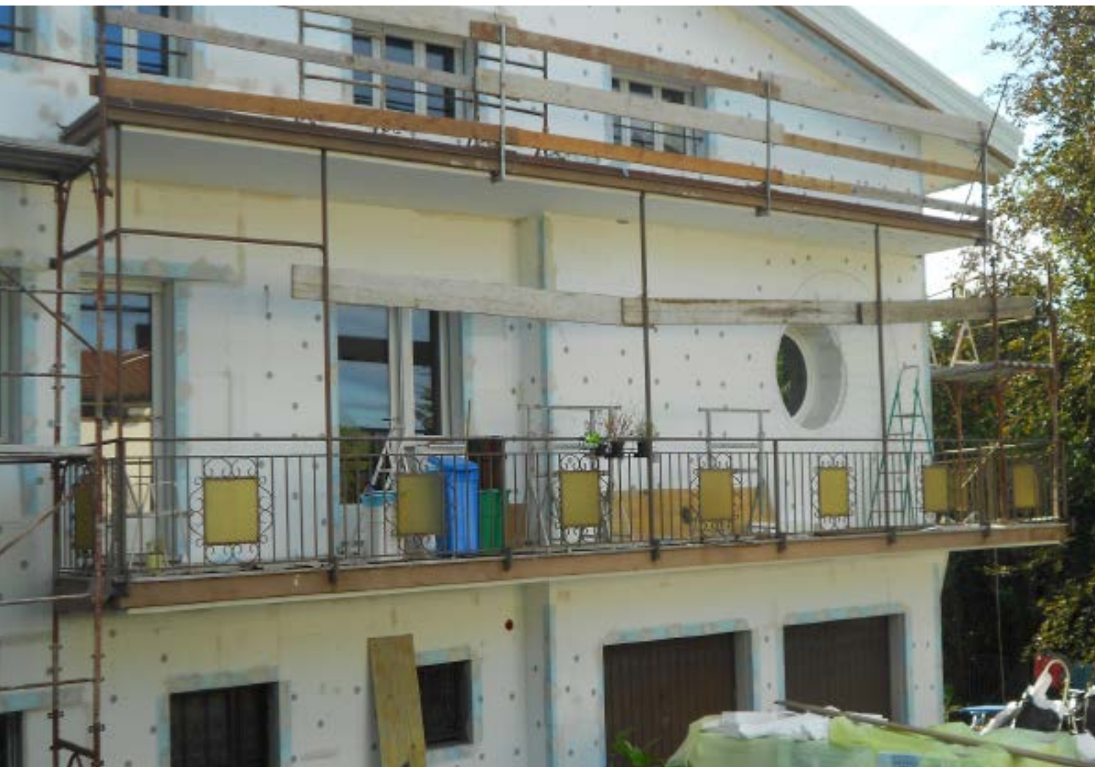
Applicazione delle lastre di isolamento
