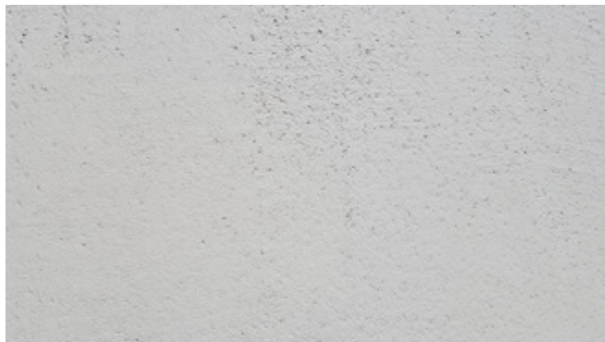
Particolare delle finiture esterne della Biblioteca Universitaria di Diritto presso Aix-en-Provence
