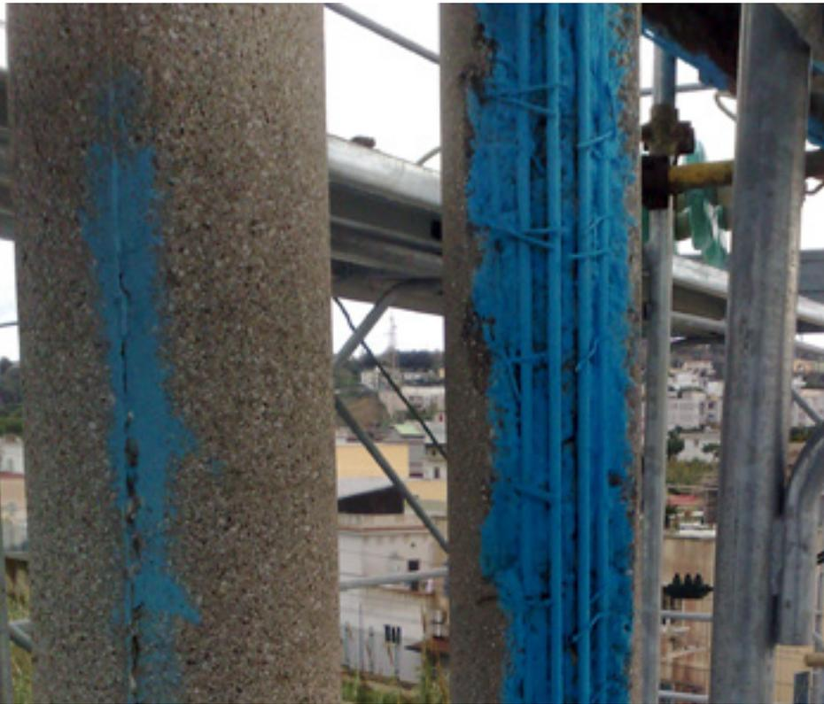
Dopo aver spazzolato accuratamente i ferri d'armatura, si procede con l'applicazione della boiaccia passivante e protettiva per i ferri d'armatura **BF 501**. Grazie alla speciale formulazione, tale prodotto svolge la duplice funzione di protezione dai fenomeni di corrosione e di ponte di aggancio tra il supporto e la malta da ripristino che viene applicata ad avvenuta asciugatura della boiaccia.
