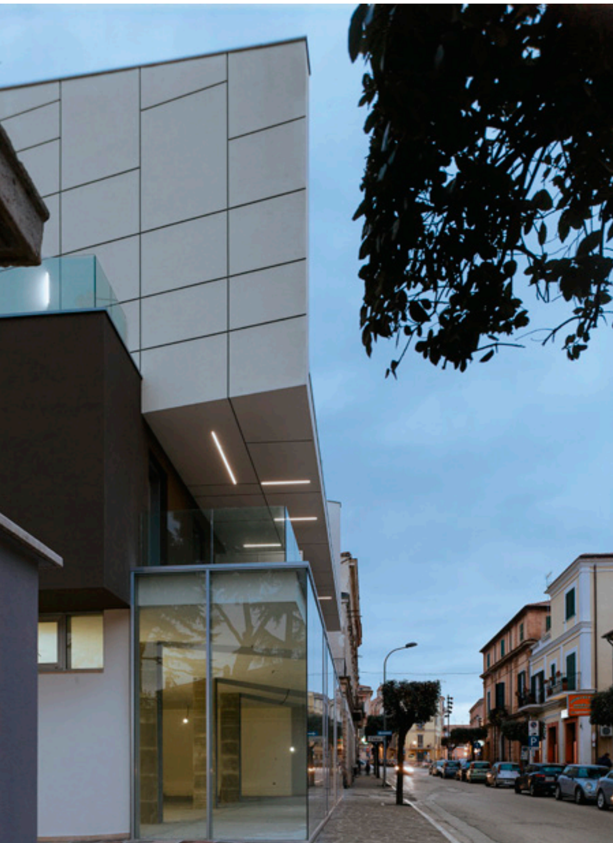
Vista dal marciapiede
