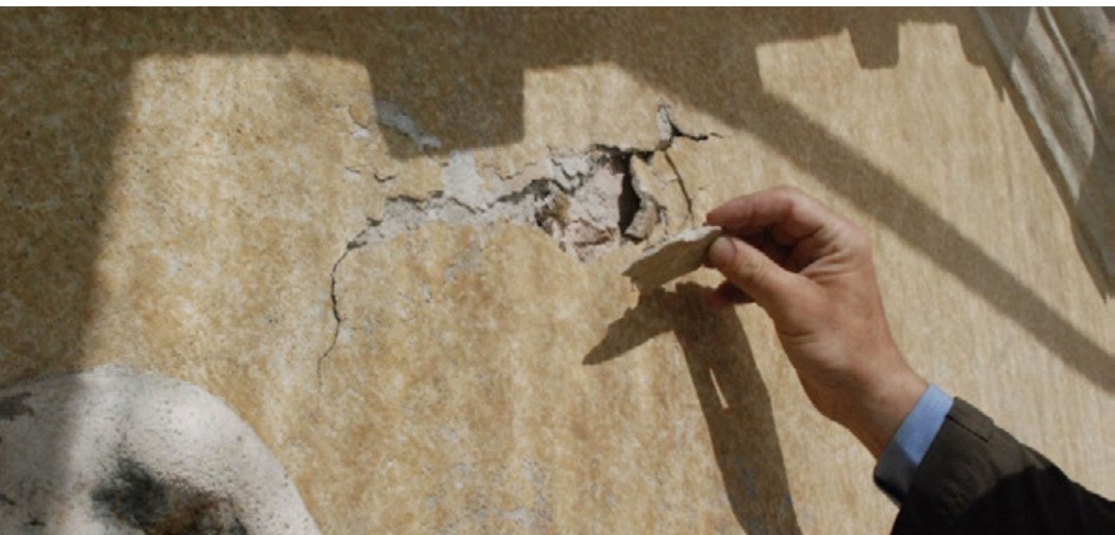
Creazione di patine biologiche sugli elementi lapidei (sopra), distacco dell'intonaco (sotto)
