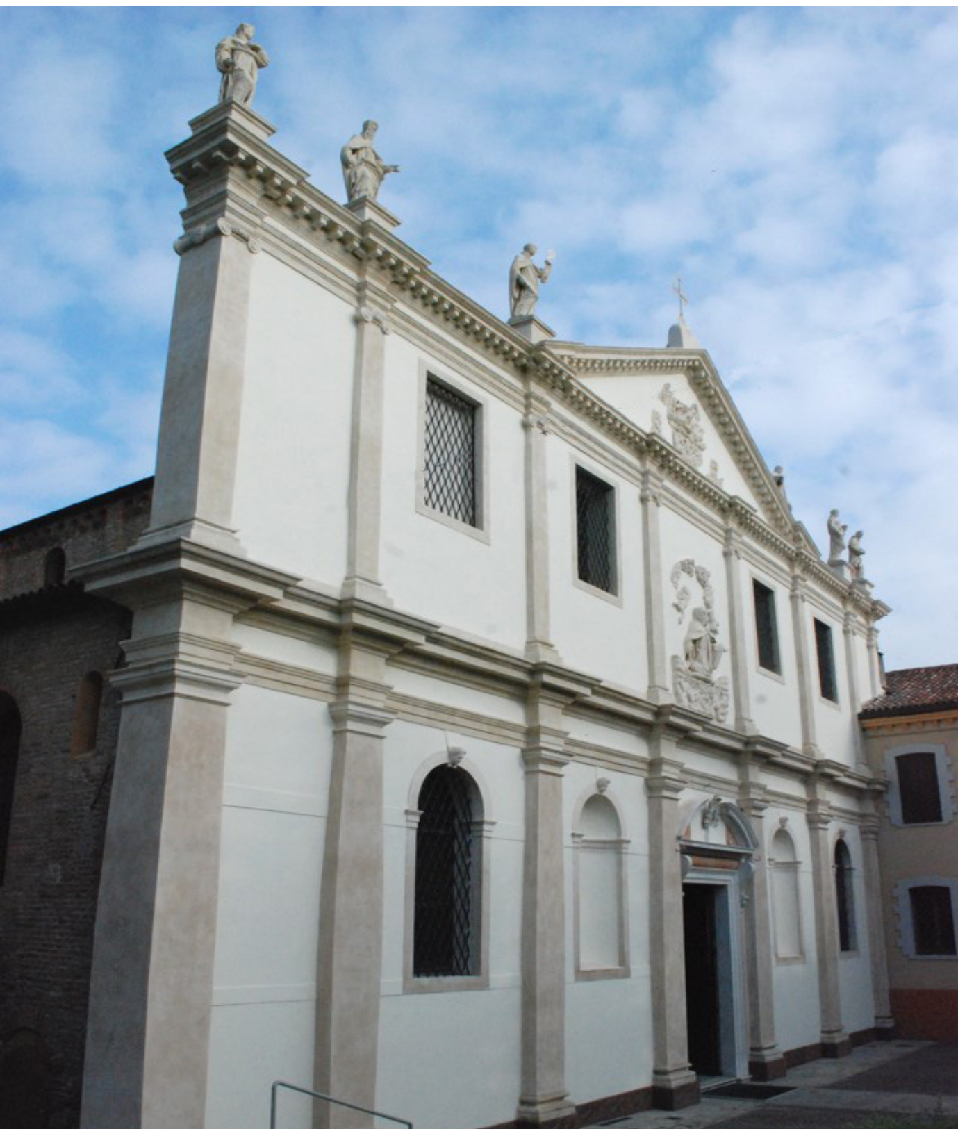
La facciata dopo l'intervento
