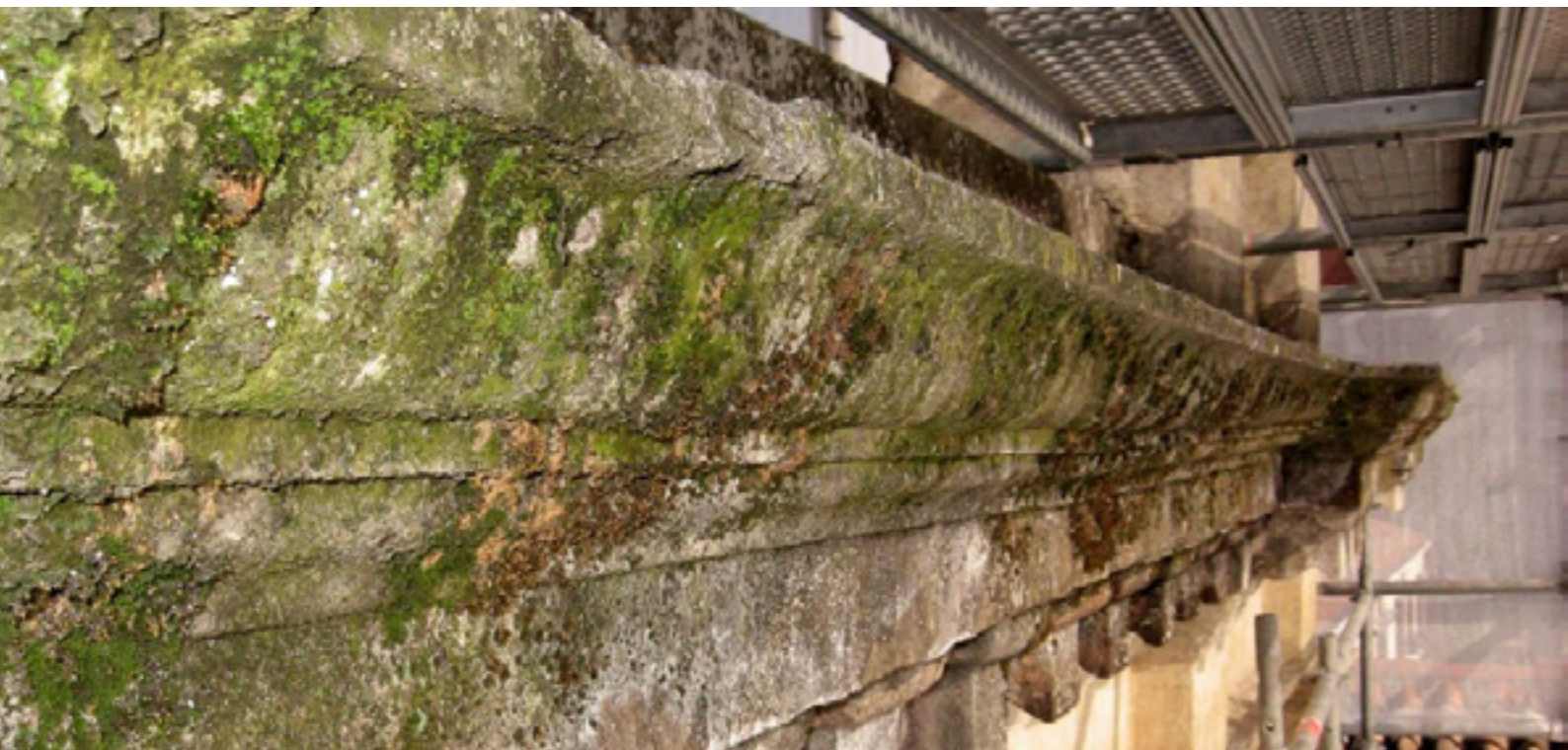
Creazione di patine biologiche sugli elementi lapidei (sopra), distacco dell'intonaco (sotto)
