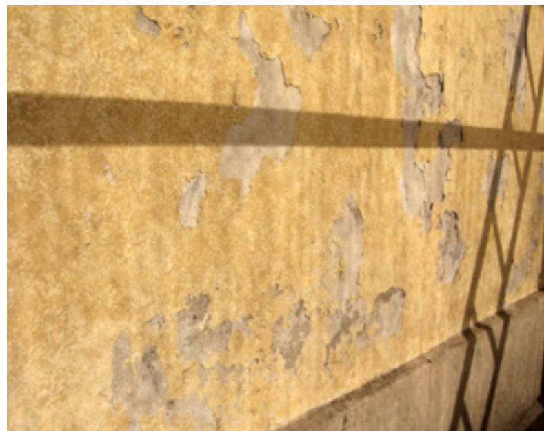
Nelle fotografie si evidenzia lo stato di degrado della copertura (a sinistra) e degli intonaci (a destra)
