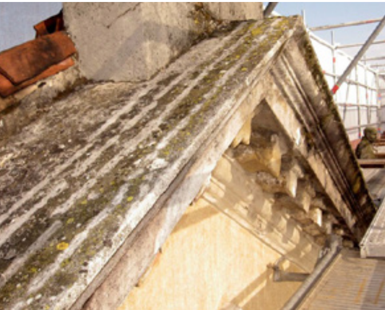
Nelle fotografie si evidenzia lo stato di degrado della copertura (a sinistra) e degli intonaci (a destra)
