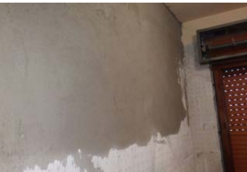
Rimozione delle vecchie piastrelle e ripristino delle superfici
