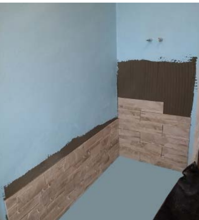
Impermeabilizzazione del sottofondo e posa delle piastrelle
