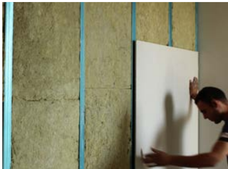
Applicazione d'isolante e lastra di cartongesso
