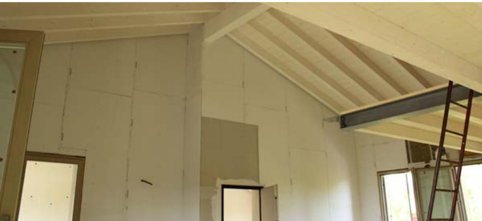
Contropareti realizzate con lastre GypsoLIGNUM e GypsoLIGNUM VAPOR
