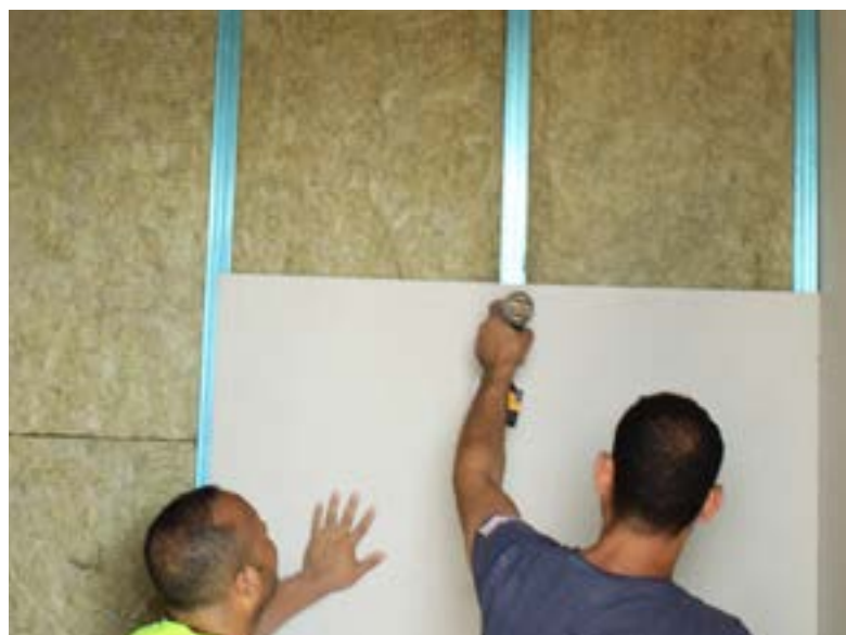
Applicazione d'isolante e lastra di cartongesso
