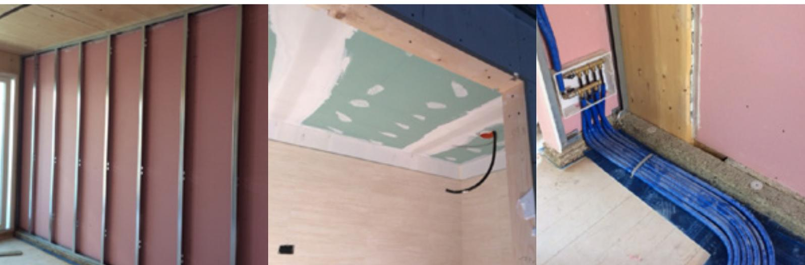
*Da sinistra a destra: parete divisoria realizzata con lastre GYPSOTECH® FOCUS TIPO DF1, soffitto realizzato con lastre GYPSOTECH® AQUASUPER DEH1, tubature posizionate sotto pavimento*
