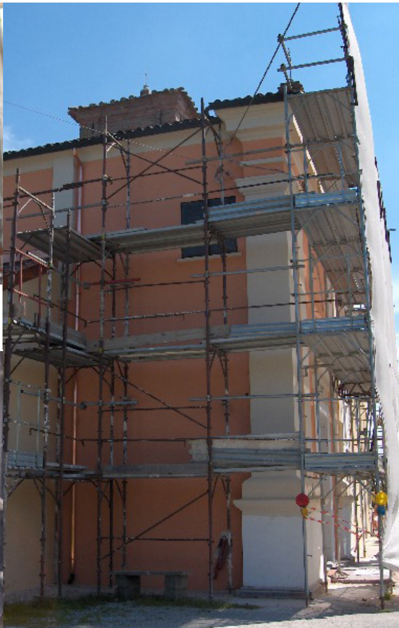
Realizzazione delle finiture
