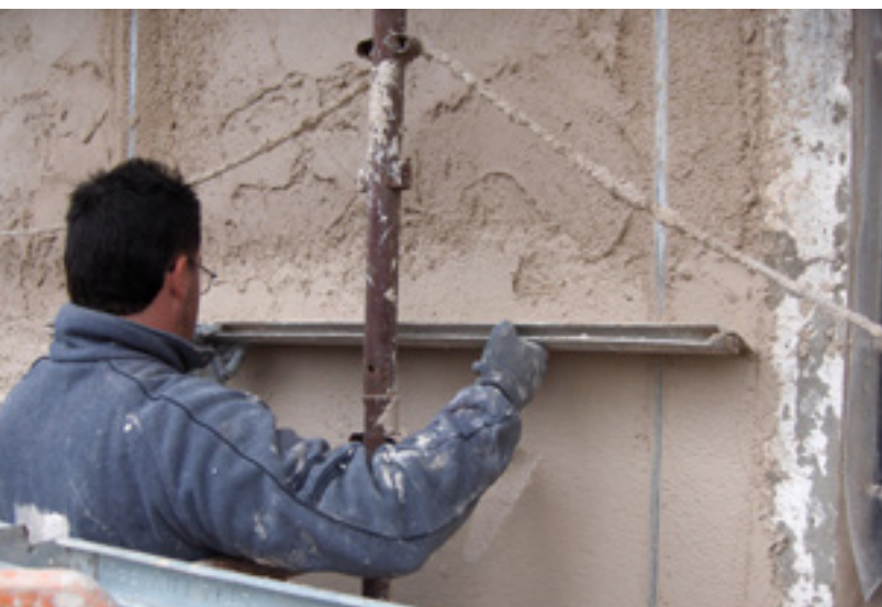
Sopra: rilevamento del livello di umidità con igrometro, sotto: applicazione di INTONACO MACROPOROSO 717
