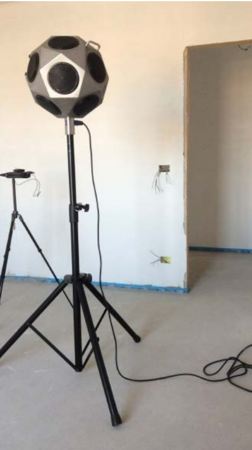
Strumentazione utilizzata per la misurazione del livello d'isolamento acustico
