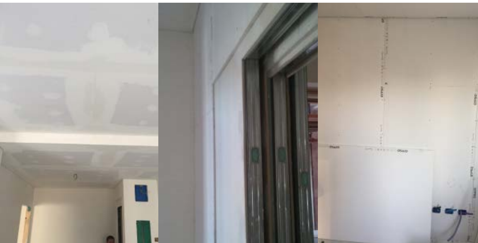
Applicazione di GYPSOTECH® GypsoLIGNUM per la realizzazione di controsoffitti, pareti e contropareti
