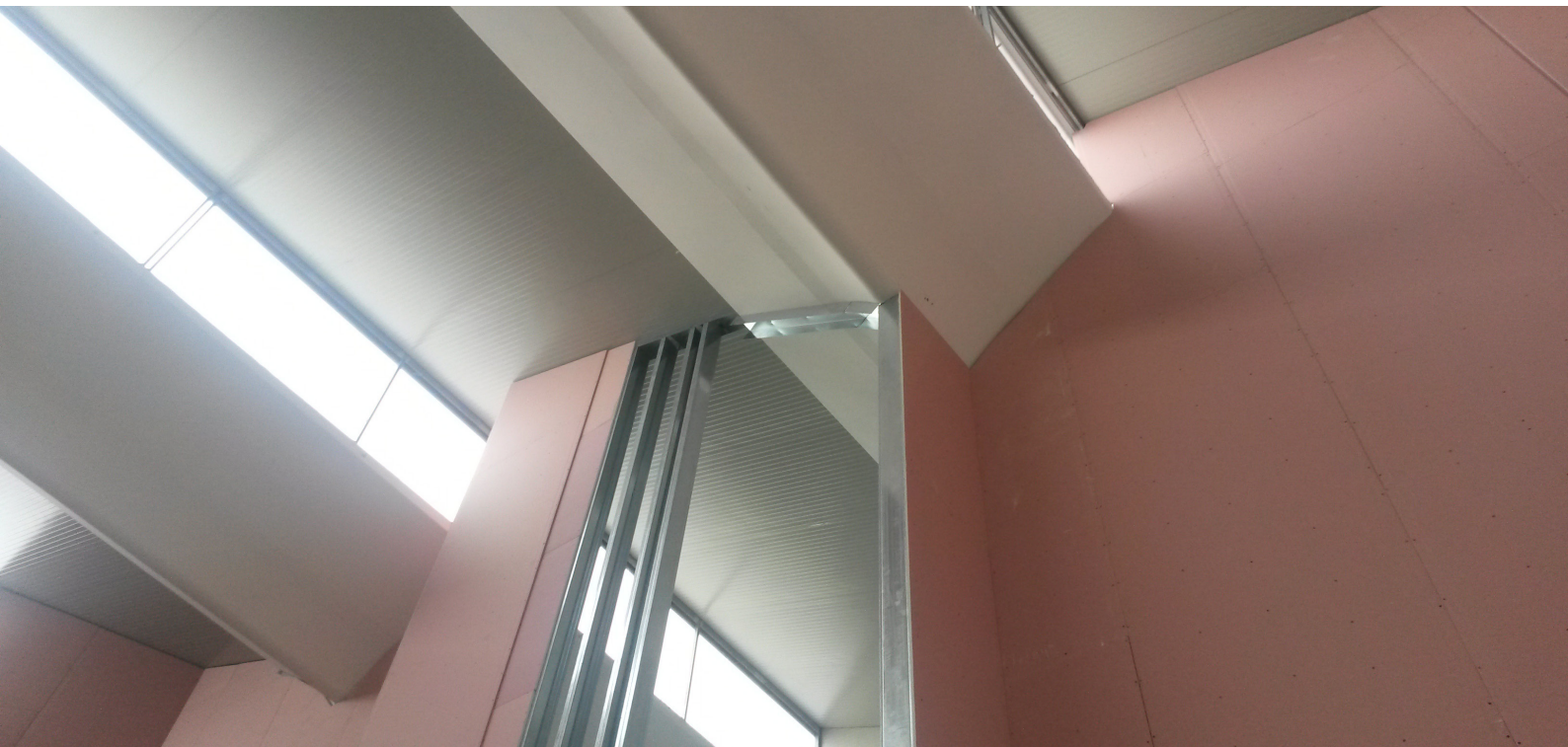
Posizionamento di giunto divisore e chiusura dello scheletro
