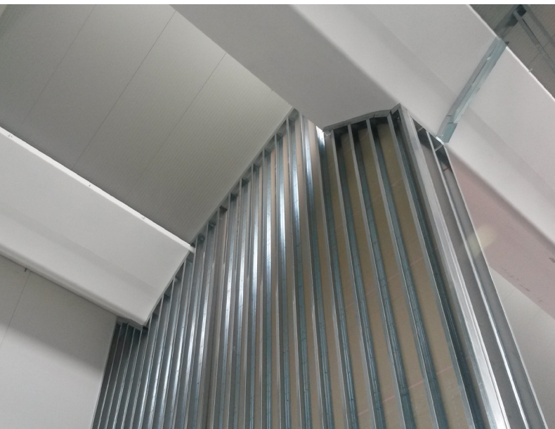
Scheletro della struttura
