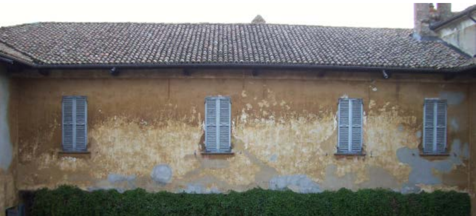
Facciata sud del cortile interno prima e dopo l'intervento
