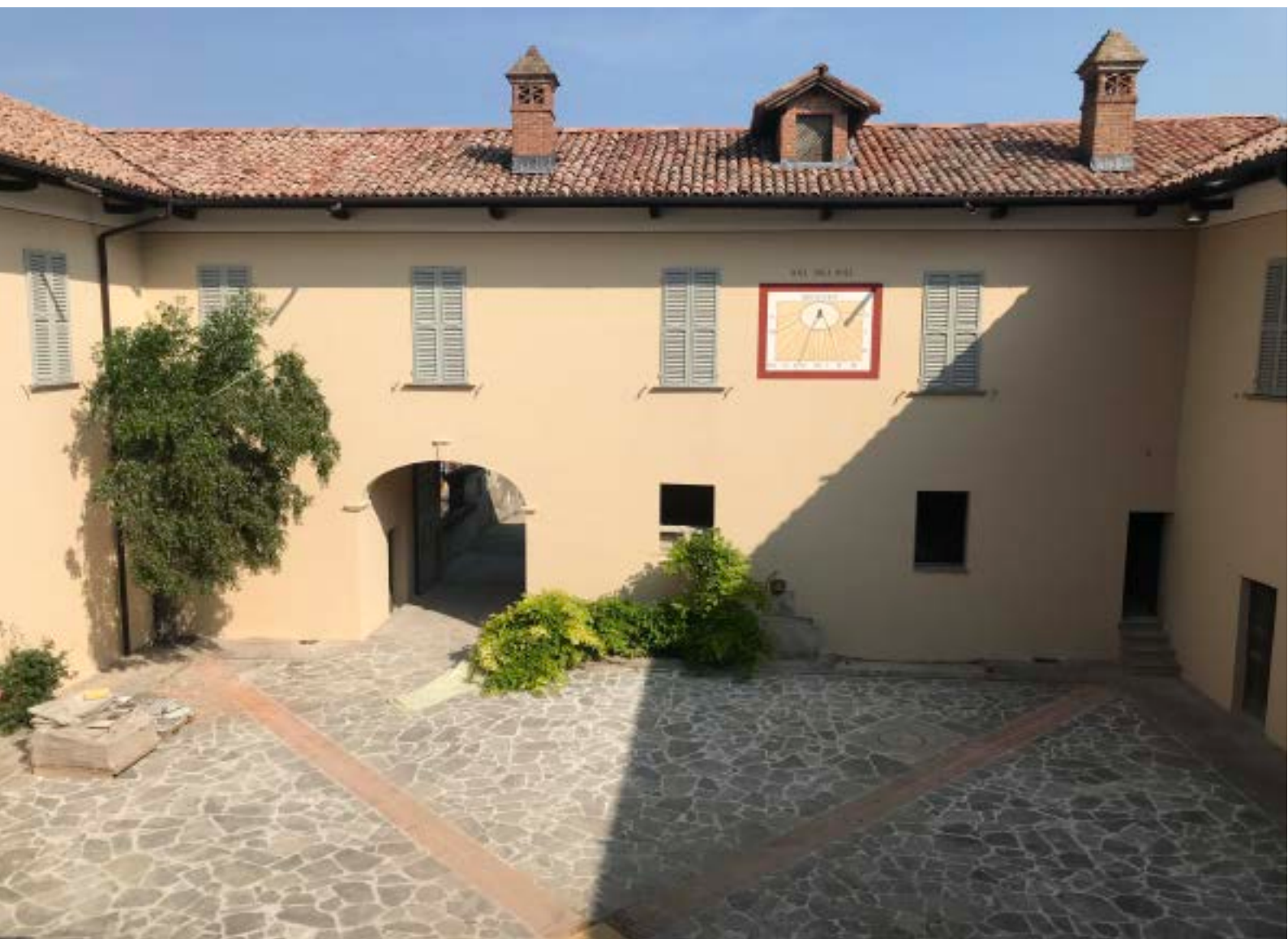
Lato nord del cortile interno dopo l'intervento
