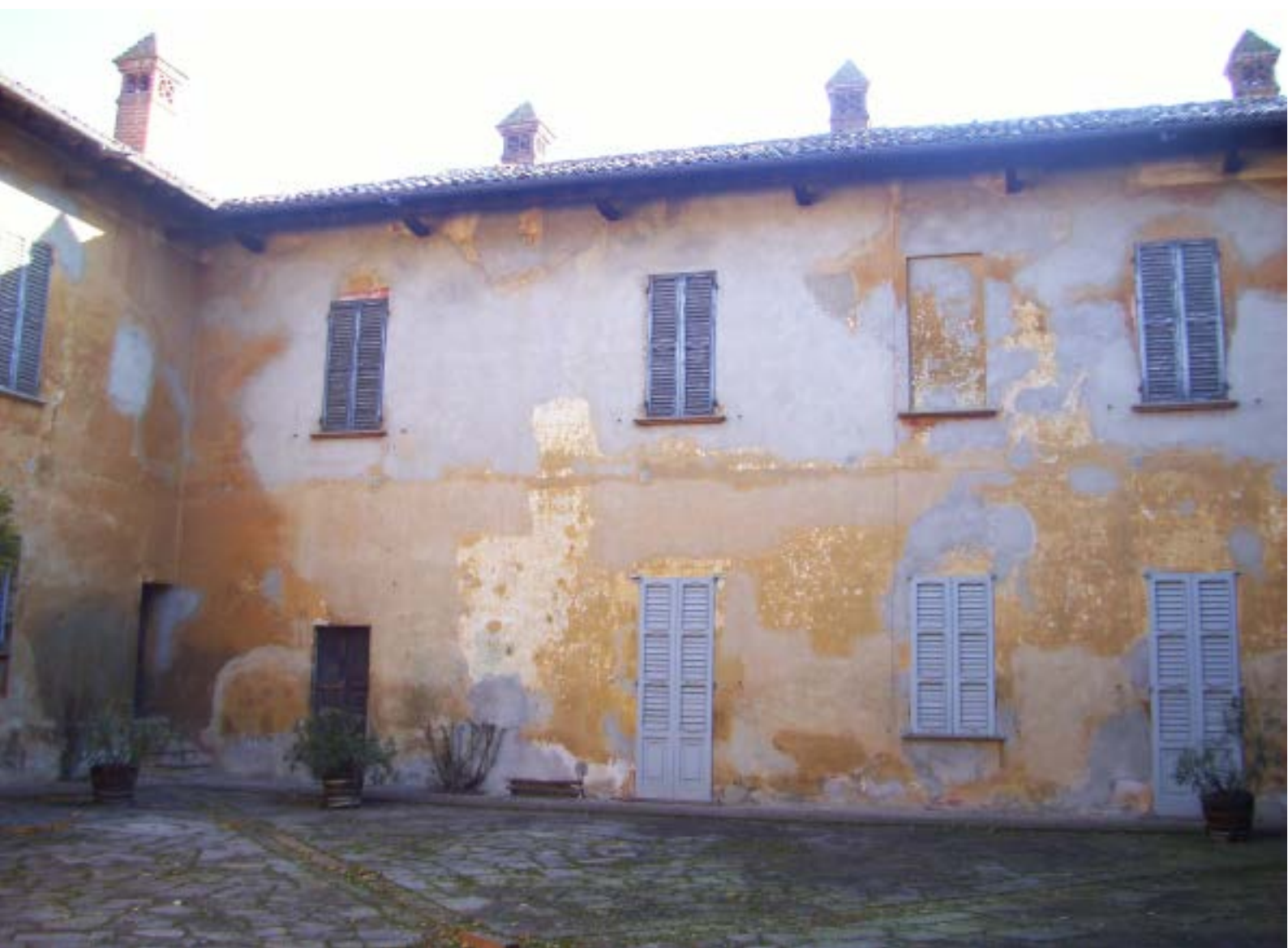
Facciata est del cortile interno prima dell'intervento
