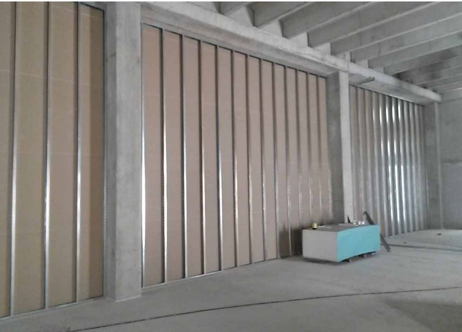
Realizzazione di pareti divisorie
