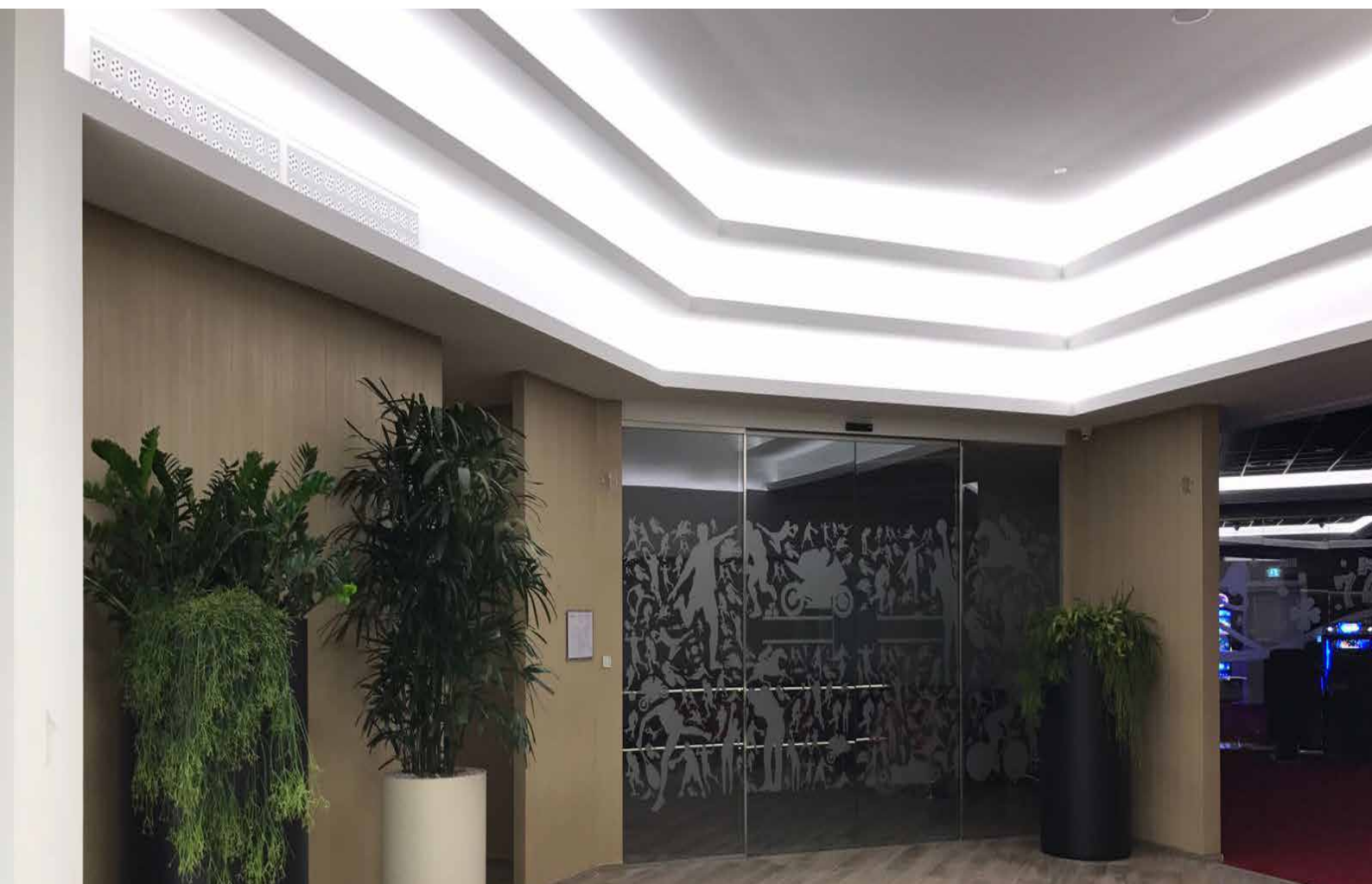
In alto: diversi ambienti finiti, in basso: controsoffitti realizzati in cartongesso con speciali gole porta led
