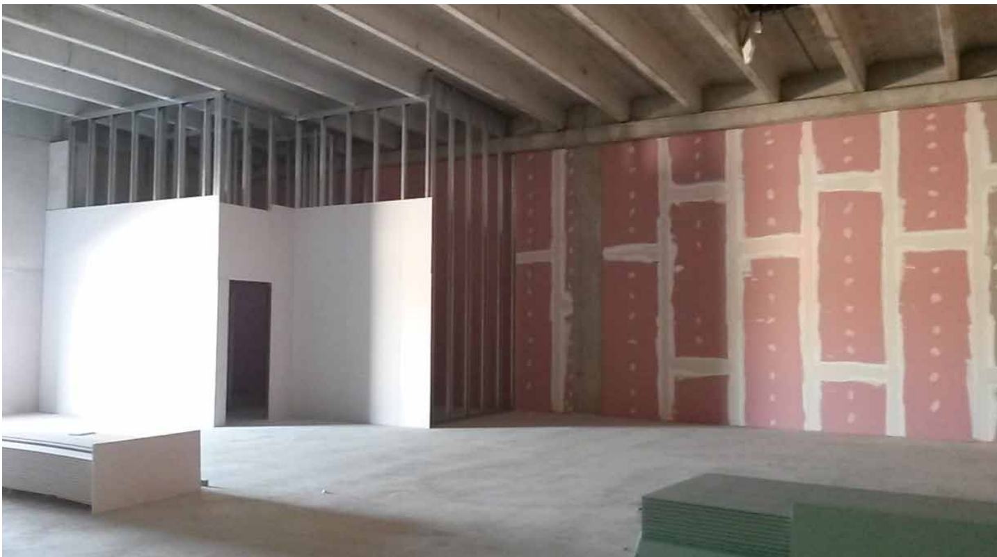
Stuccatura dei giunti e punti di avvitatura
