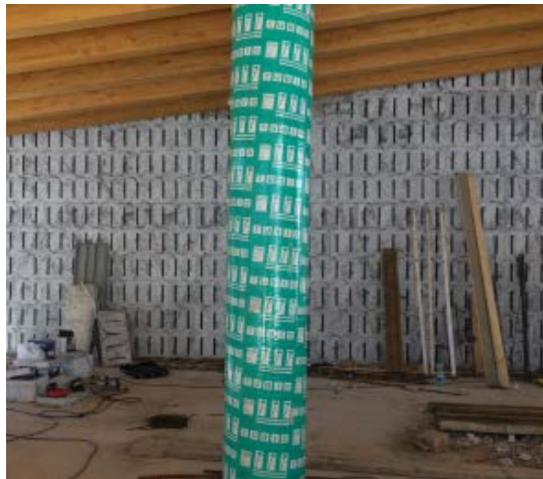
Pareti perimetrali interne rivestite in EPS
