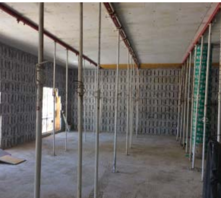
Pareti perimetrali interne rivestite in EPS
