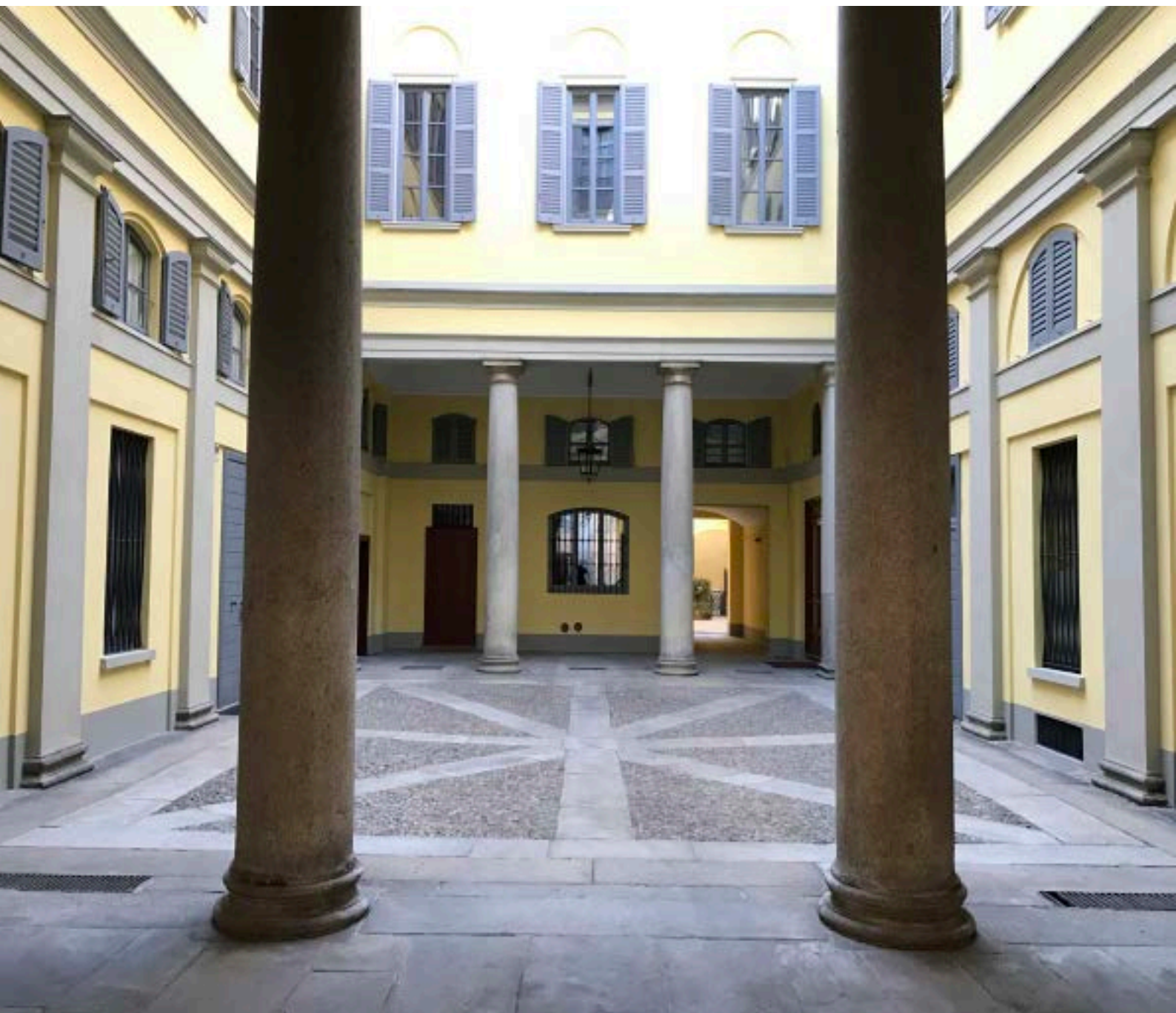
Il cortile interno dopo l'intervento
