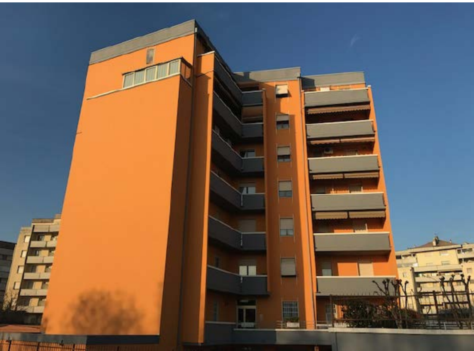
Lato est dell'edificio dopo l'intervento
