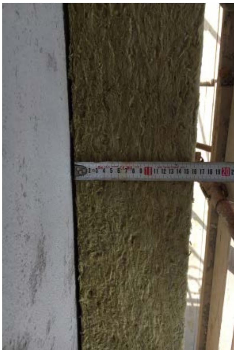
*Applicazione delle lastre isolanti in lana di roccia di 16 cm*
