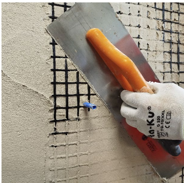
Figura 1 – Sistema FRCM di Fassa Bortolo con rete
