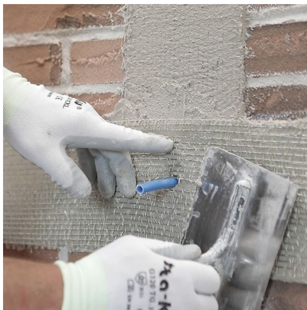
Figura 2 – Sistema FRCM di Fassa Bortolo con tessuto
